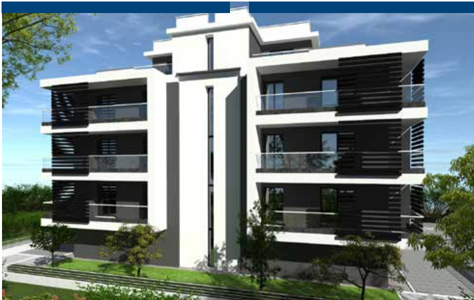
Saliceta | Stradello Chiesa | palazzina
